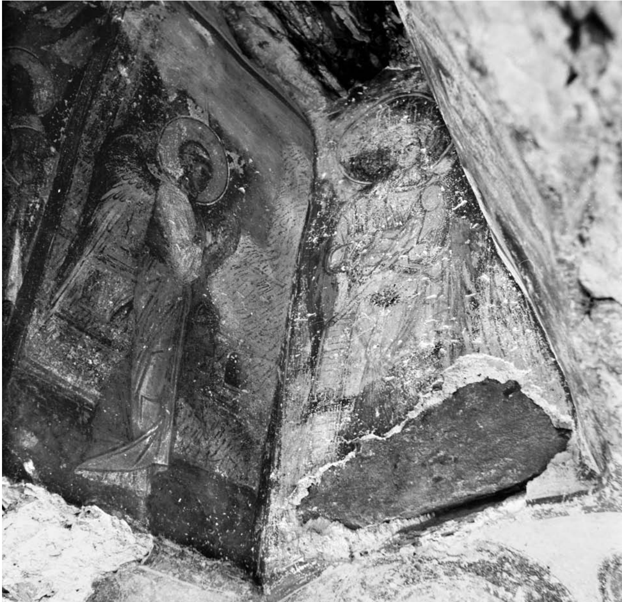
Сл. 56. БЕЛАЈА, СЕВЕРОИСТОЧНА СТРАНА ПЕЋИНСКЕ ЦРКВЕ, ГОРЊИ ДЕО, СТАЊЕ ИЗ 1966
